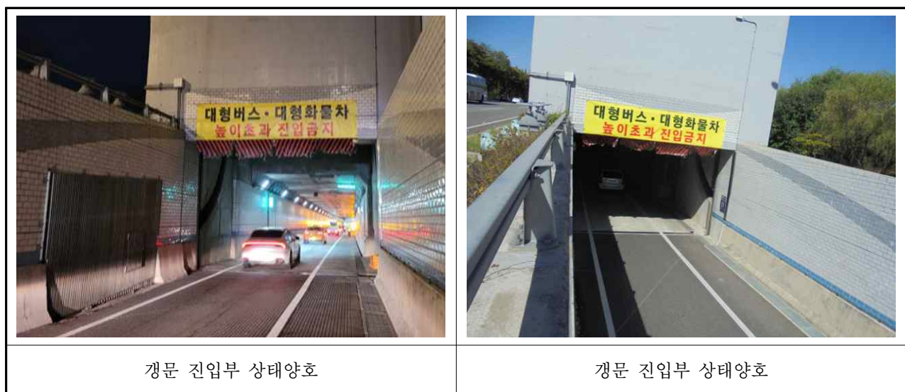
【사진 3.3.36】갯문 손상현황
