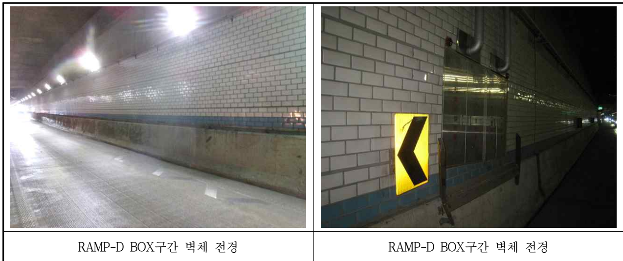
【사진 3.3.21】 BOX구간 벽체 전경
