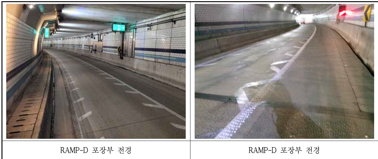
【사진 3.3.29】 포장부 전경
