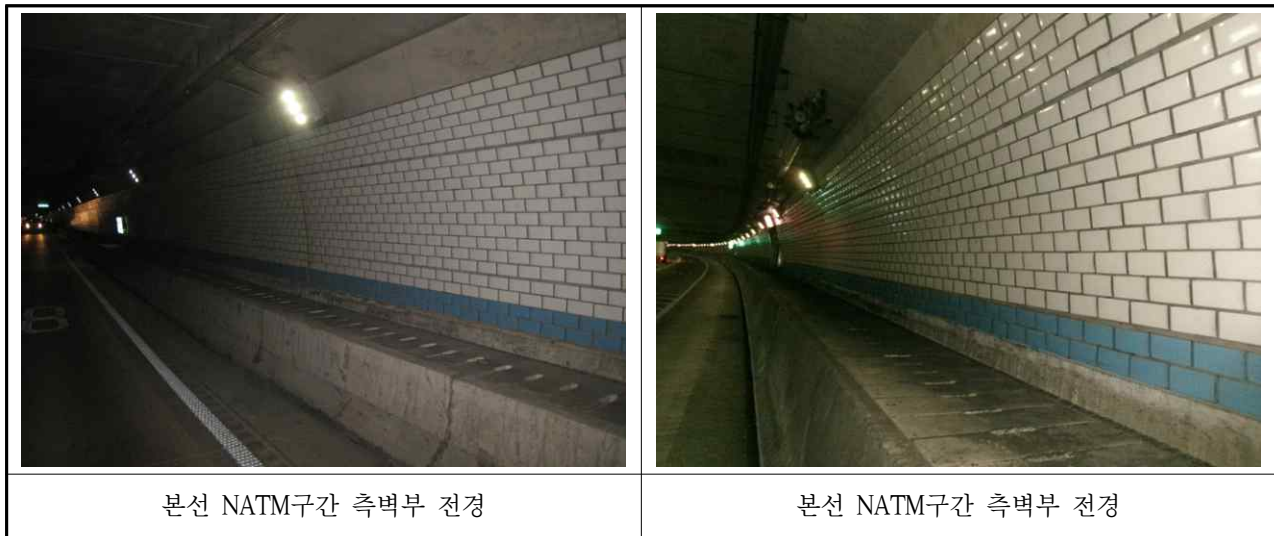
【사진 3.3.7】 NATM구간 측벽부 전경
