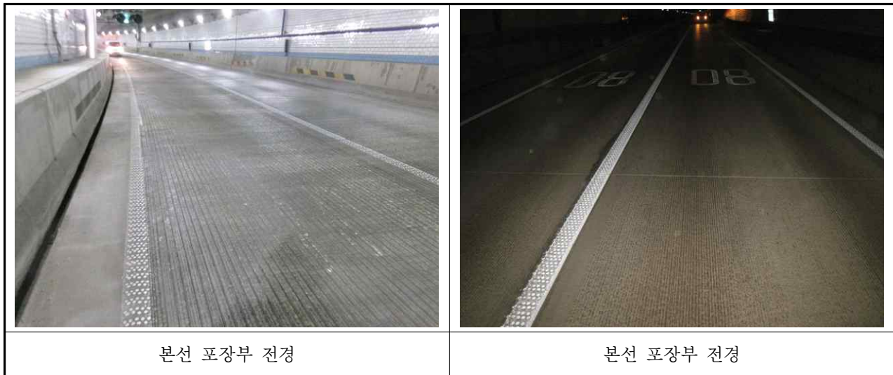
【사진 3.3.11】 포장부 전경
