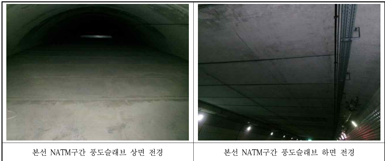
【사진 3.3.9】 NATM구간 풍도슬래브 전경
