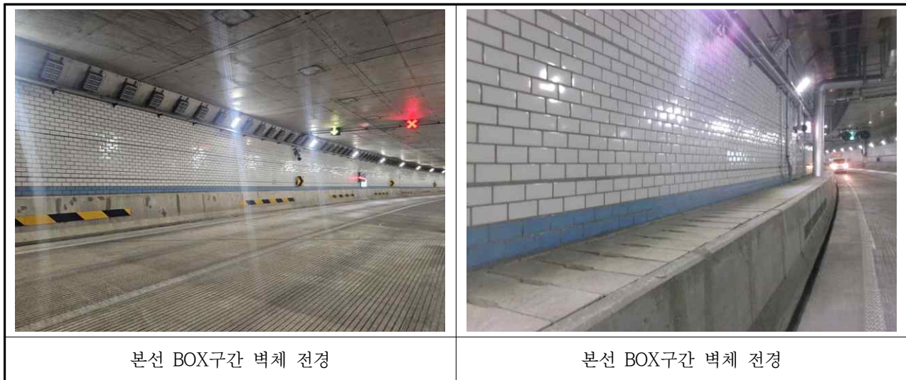
【사진 3.3.3】 BOX구간 벽체 전경
