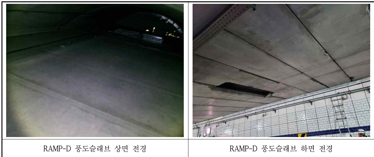
【사진 3.3.27】 NATM구간 풍도슬래브 전경
